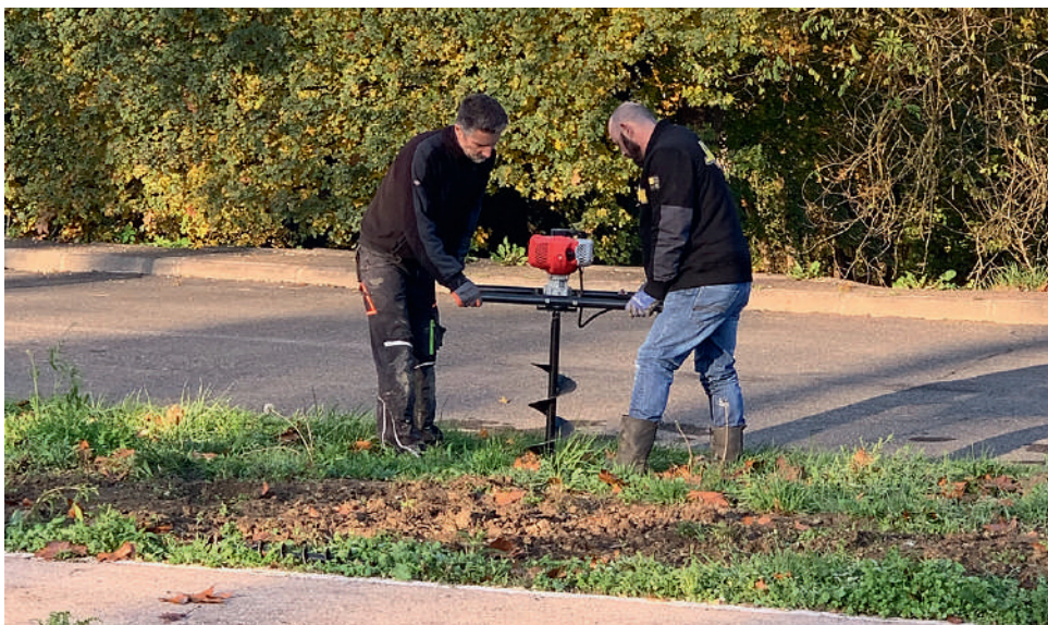
Préparation en amont des trous
