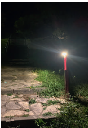
Lampadaires voies piétonnes
